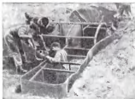
Рис. 2. Сборка сооружения для полкового медицинского пункта
